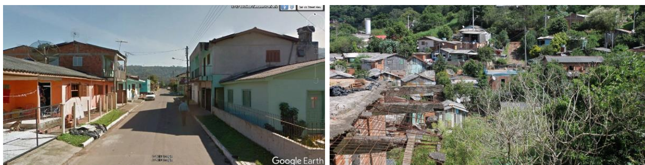
Figura 3. Rua do loteamento regular (direita) e ocupação irregular (esquerda) do Bairro São José.
