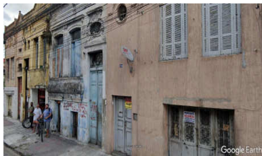
Figura 3. Residências encortiçadas. Rua Brás Cubas, 246/252. Vila Nova. Fonte: Google Earth, agosto/2021.
